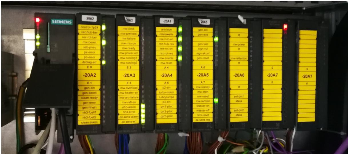
Abbildung 36: Siemens SPS der Nemo-1-Anlage (Quelle: eigene Darstellung)
